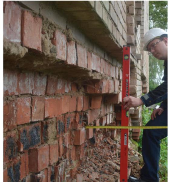
Рис. 6 – Инструментальное измерение параметров дефектов
