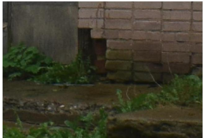
Рис. 10 – Участки разрушения кирпичной облицовки фасада
