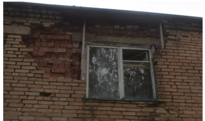
Рис. 22 – Участки разрушения кирпичной облицовки фасада
