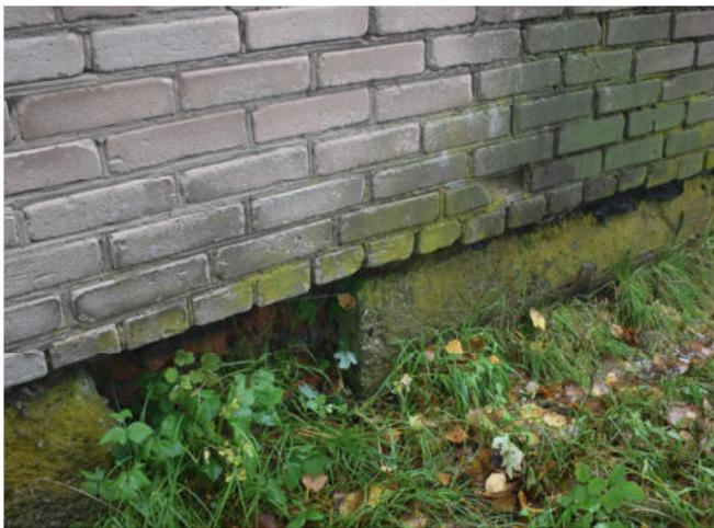
Рис. 21 – Сколы бетона цоколя. Биопоражение
