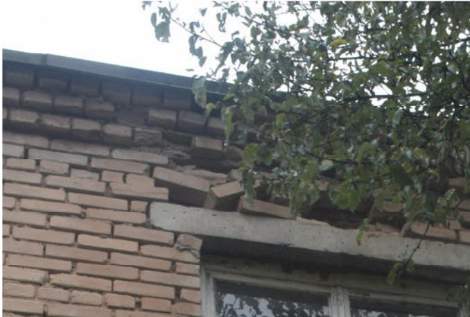
Рис. 15 – Участки разрушения кирпичной облицовки фасада
