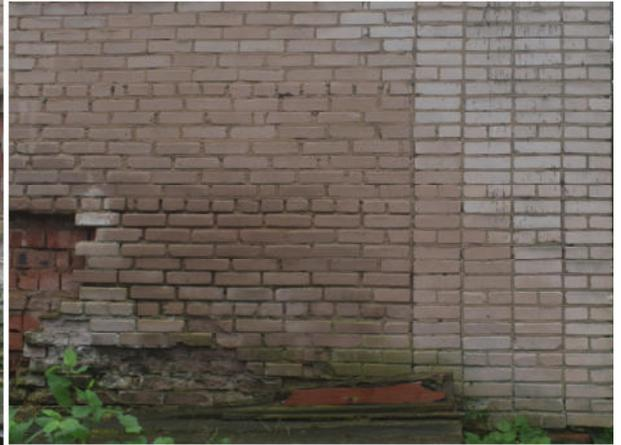
Рис. 20 – Участки разрушения кирпичной облицовки фасада. Замачивание конструкции стен
