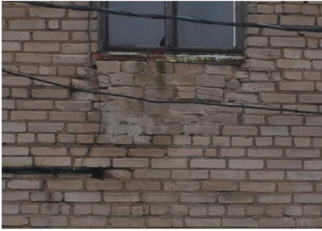
Рис. 13 – Участки разрушения кирпичной облицовки фасада
