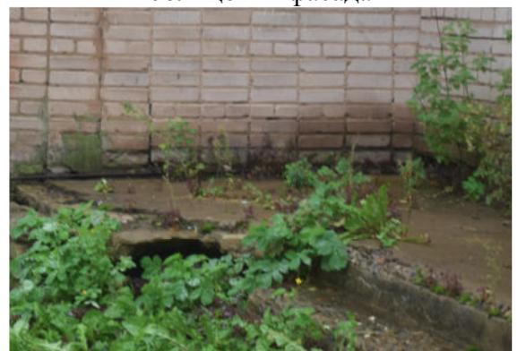
Рис. 12 – Сколы бетона входных групп, биопоражение
