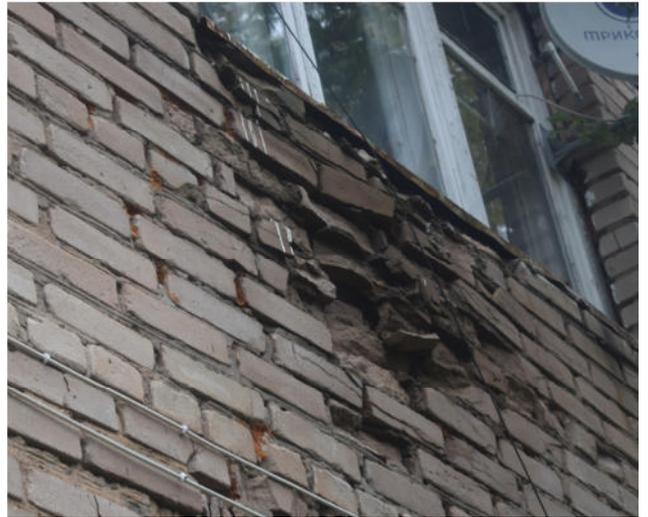
Рис. 14 – Участки разрушения кирпичной облицовки фасада
