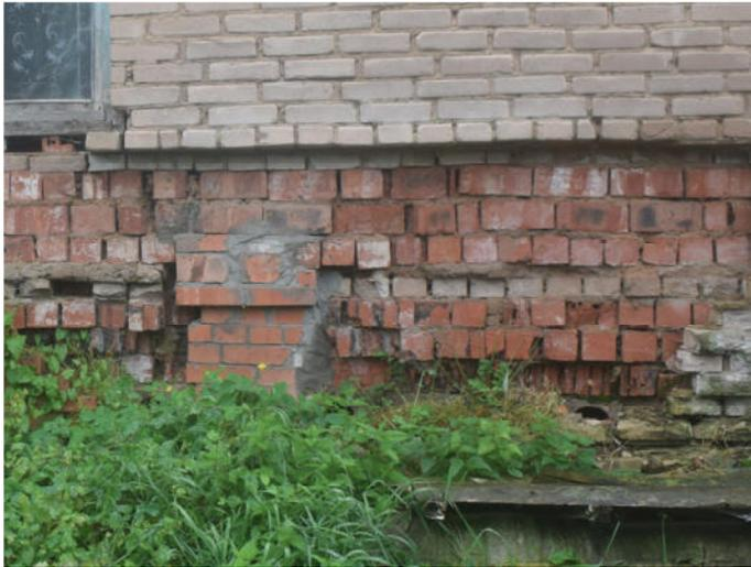
Рис. 19 – Участки разрушения кирпичной кладки несущей стены
