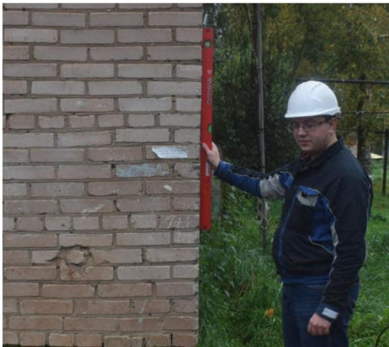
Рис. 3 – Инструментальное измерение параметров дефектов
