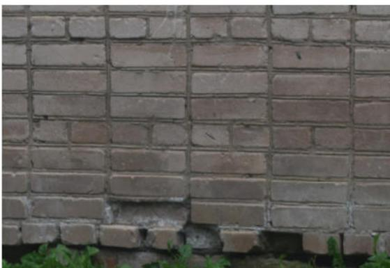
Рис. 11 – Участки разрушения кирпичной облицовки фасада
