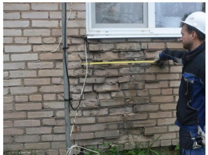
Рис. 4 – Инструментальное измерение параметров дефектов
