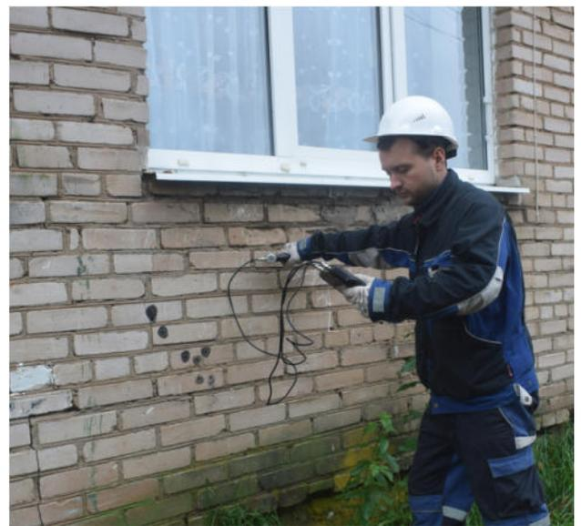
Рис. 8 – Измерение прочностных характеристик конструкций ультразвуковым способом
