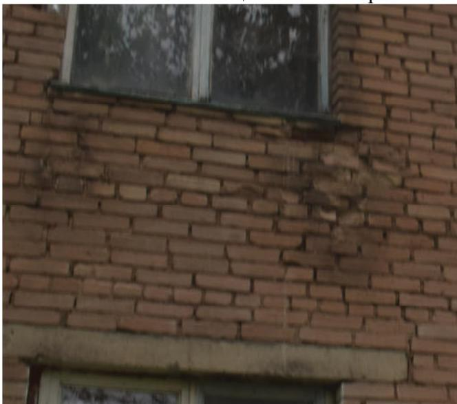
Рис. 23 – Участки разрушения кирпичной облицовки фасада
