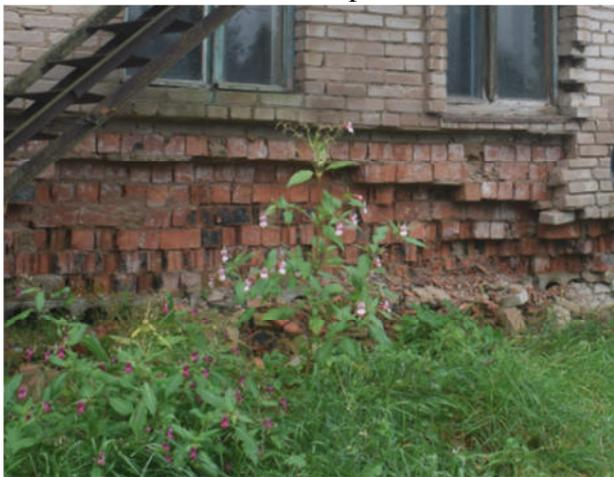
Рис. 17 – Участки разрушения кирпичной кладки несущей стены
