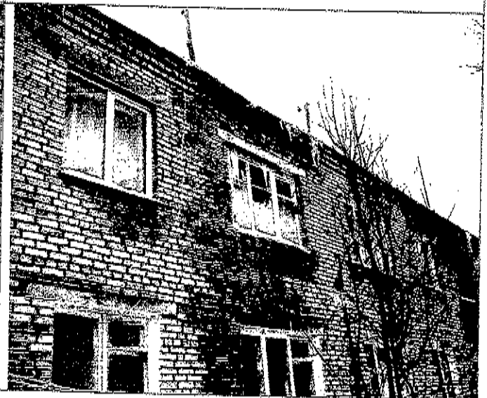
Фото 6. Разрушение парапета и увлажнение стен.
