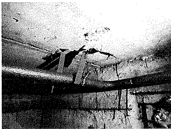
Не закреплены подвесы крепления труб
