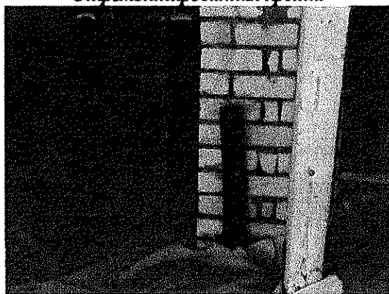
Фановая труба не выведена за пределы кровли
