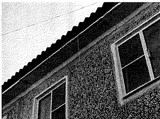
Шелушение окрасочного слоя карниза и цоколя
