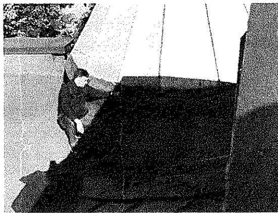
Не обеспечена прочность сцепления слоев
