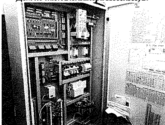
Шкаф управления и лифтовая лебедка в машинном помещении
